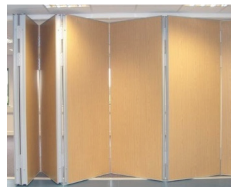
Modulair bouwen: Mobile binnenwanden in kantoor- & studieruimte
